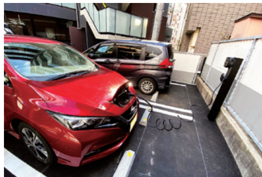
新築集合住宅向けの施工実施
