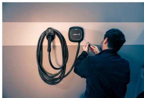
EV充電器設置工事
