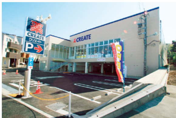
ドラッグストア 新築工事
