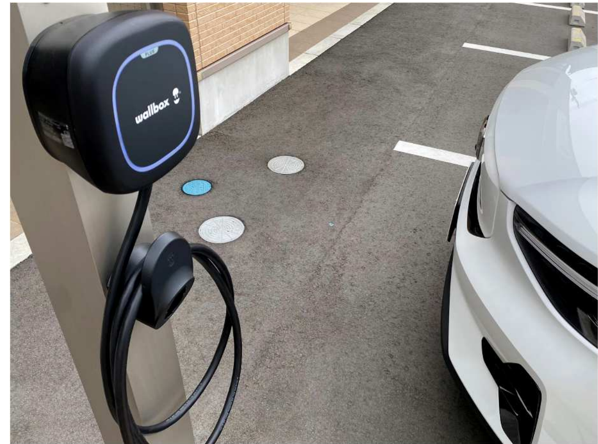
Wallbox”Pulsar Plus”を国内初施工
