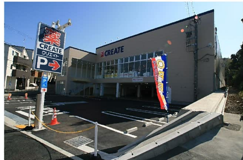
ドラッグストア 新築工事
